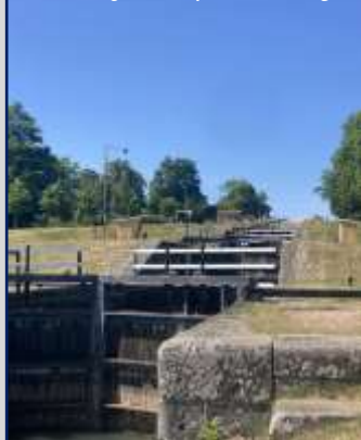
De sluisentrapp van Berg
