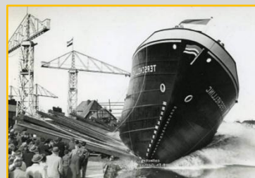
Een tewaterlating in 1951. Dwarshellings aan het Winschoterdiep bleven nog lang in zwang.
