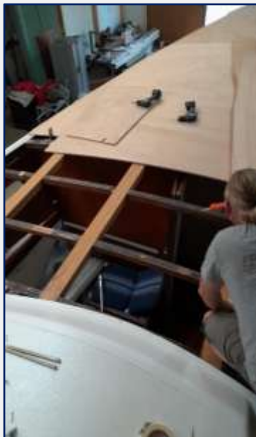
Platen weghalen en lijm aanbrengen
