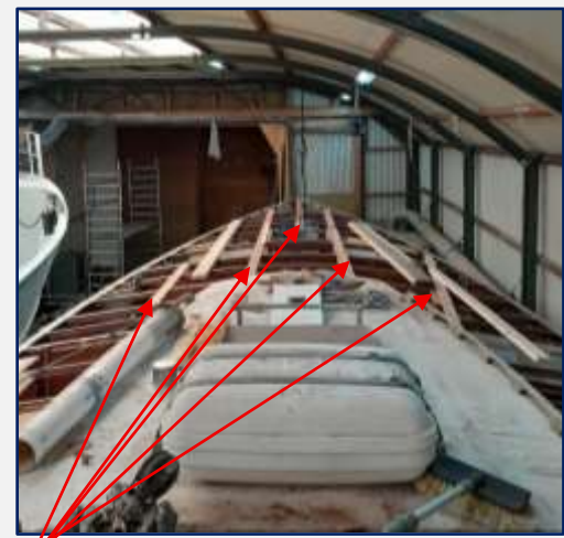
alle langsspanten op hun plek gelijmd
