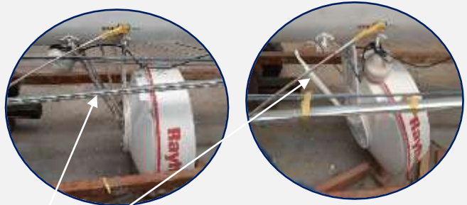
De steun voor en na verven met 2 lagen Hammerite
