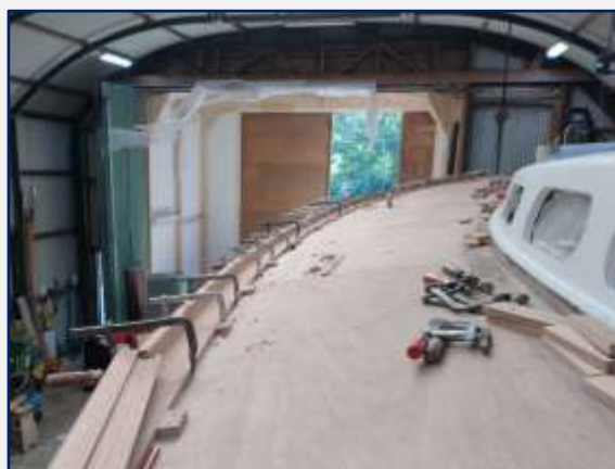
montage voetrail op lijfhout
