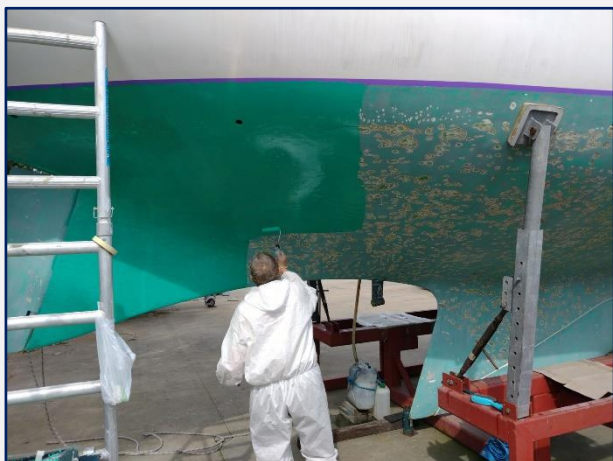
Eerste laag Gelshield aanbrengen
