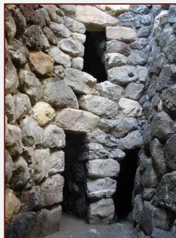
Verdiepingen in huizen
