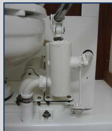
pomphuis/vloer na reanimatie
